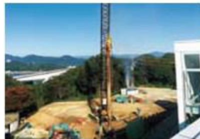
既存館西側で着々と進む工事風景
