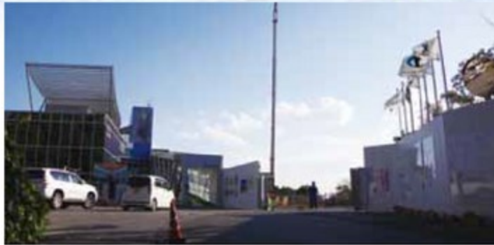
リニューアル工事が始まる既存館と新館建設工事が進む西側(右手)
