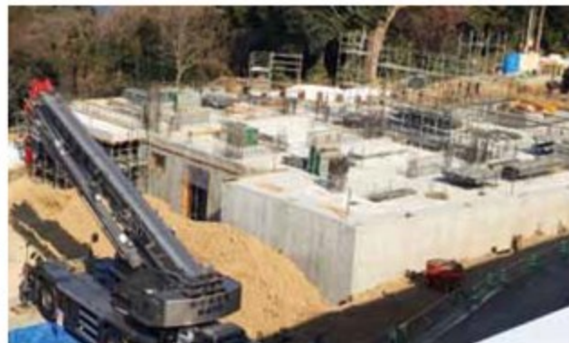
着々と進んでいる新館建設
