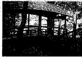
愛媛県大洲市河辺町の「御幸の橋」
