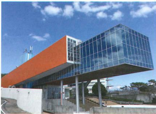
南西の海側から見た記念館 今年7月からこの風景の道路(左側)は閉鎖します
